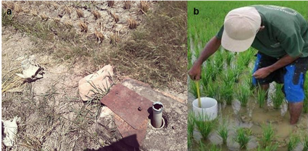
Gambar 4. Profil lahan sub optimal dan kegagalan penempatan sumur bor di zona tidak prospek air tanah di Ambarawa Timur (a). Rekayasa aquifer storage recovery (ASR) pada sumur tepat mendapatkan zona prospek (b), besarnya curah hujan dapat dialirkan untuk mengisi akuifer.
