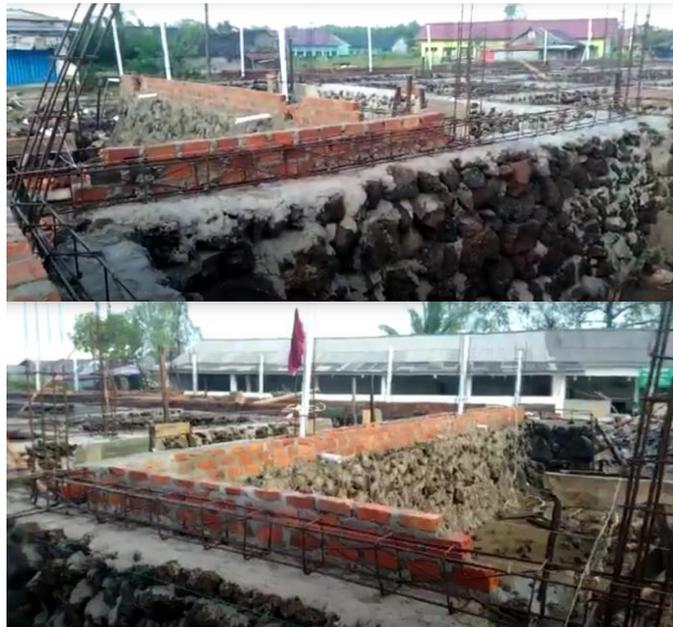
**Gambar 9. Kondisi Lahan dengan Pemasangan Pondasi Dasar**
