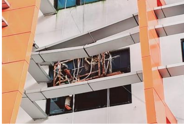
Gambar 3. Sun Shading Gedung Kanwil DJP Bengkulu - Lampung Patah
