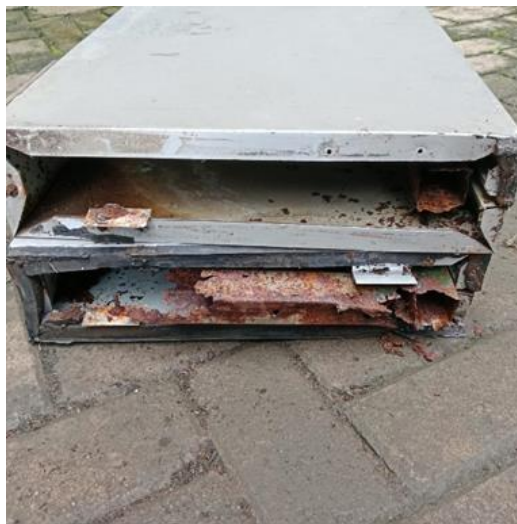
Gambar 4. Sun Shading Gedung Kanwil DJP Bengkulu - Lampung Jatuh
