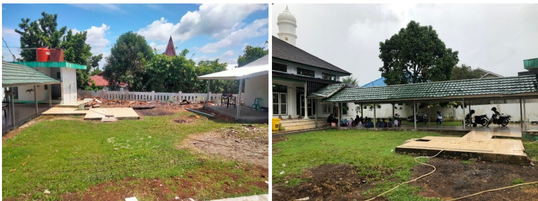
Gambar 3. Kondisi Lokasi yang akan dibangun Gazebo
